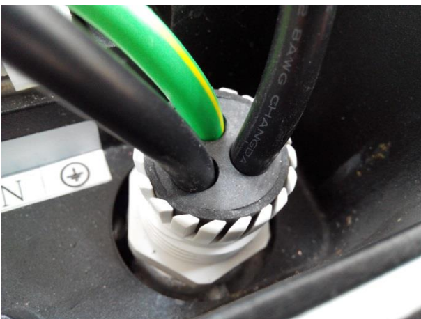
圖三 使用正確防水塞頭進行配線作業
